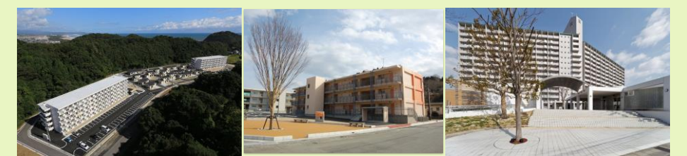
施工実績の一例（左から）災害公営住薄磯団地、公営住宅船戸団地6号棟、災害公営住宅内郷砂子田団地
