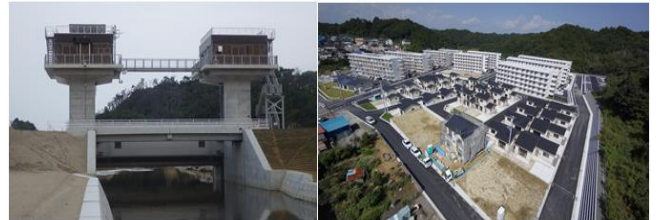
公共災害復旧工事（神白水門）災害公営住宅新築工事（永崎団地）
