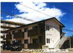
千鶴建設工事
