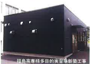
福島高専様多目的実習場新築工事
