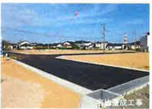
千鶴建設工事
