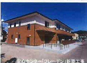
安心センター「ブレーデン」新築工事
