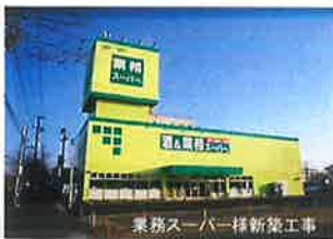
業務スーパー様新築工事
